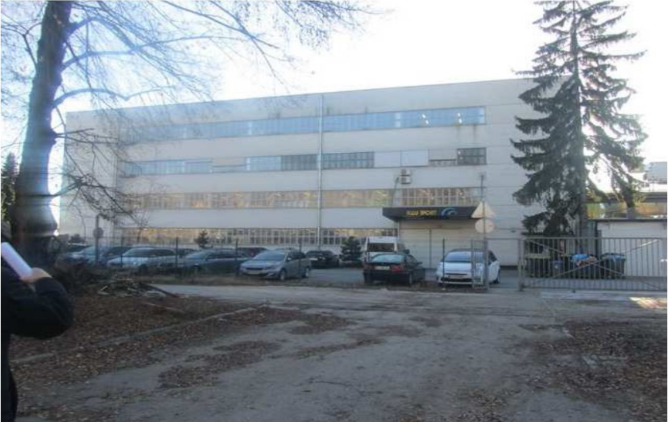
Poslovno – skladiščni objekt v Zgornji Šiški
